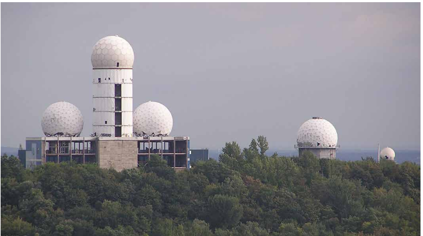
Berliner Teufelsberg, ehemalige Abhöranlage, Foto: Wikimedia, Axel Mauruszat
