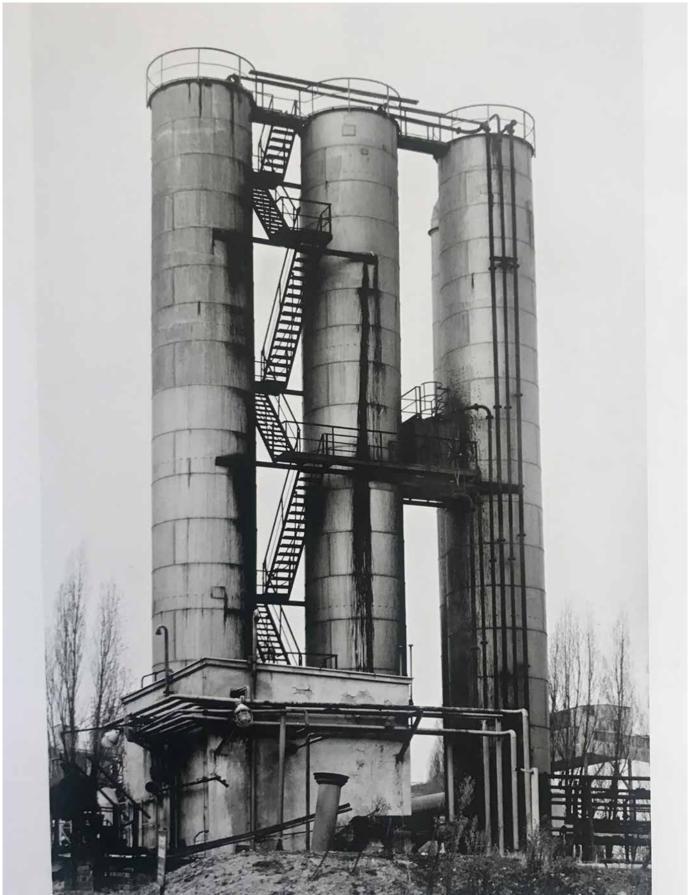
Phenolanlage im Alten Gaswerk Prenzlauer Berg Foto: Eberhard Klöppel
